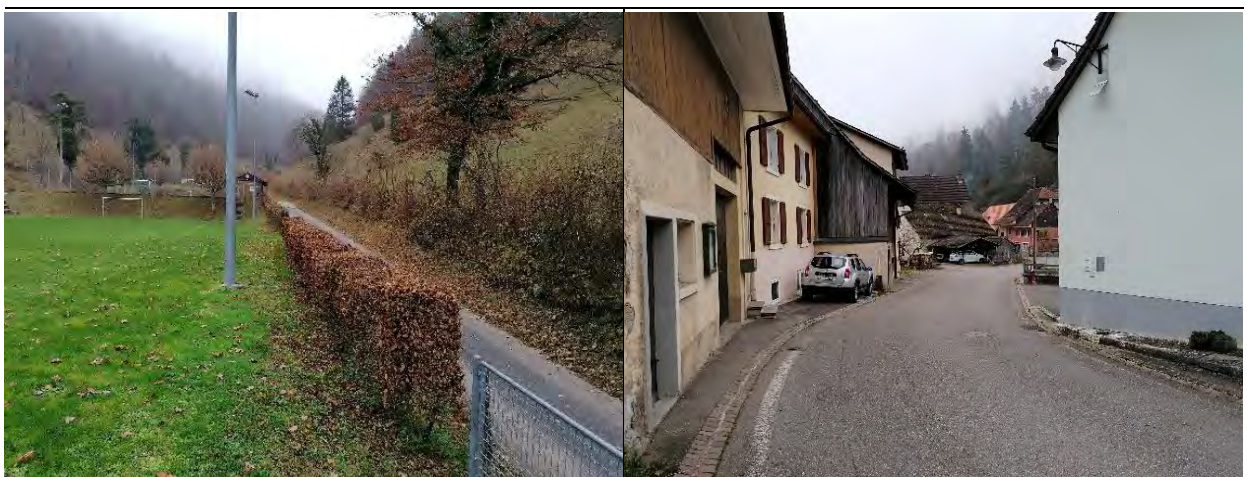
Abb. 14: Der Chälengrabenbach im Zonenplan Siedlung (Bild links) resp. der Dittingerbach (Bild rechts) im Teilzonenplan Dorfkern verlaufen eingedolt unterhalb der Strasse (Quelle: Jermann AG, 2021).
