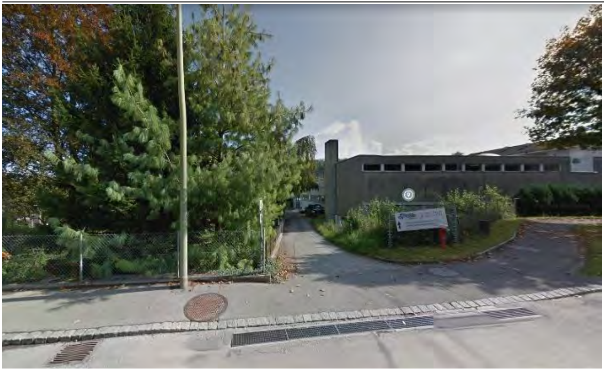
Abb. 23: Ansicht von der Nationalstrasse «Baselstrasse» auf den Fussweg, unter welcher die Dole des Dittingerbachs verläuft (Quelle: Google Maps, 2014).
